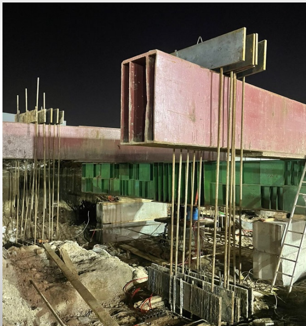
Статическое испытание нагрузкой 1000тн
